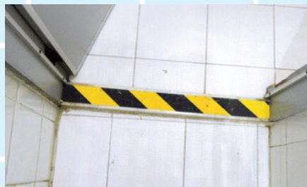
圖1：在門檻加裝一條與地板有強烈顏色對比的防滑條，可提醒長者出入時小心門檻，以防絆倒。
