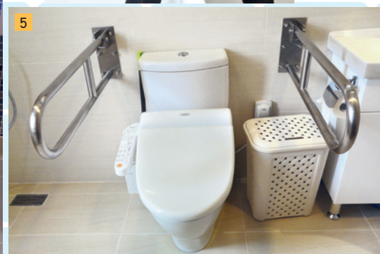
圖2：長者若需要坐着沐浴，應考慮在浴缸或沐浴間內牆安裝橫向扶手，有助長者沐浴時安全活動。 圖3：在浴缸或企缸進出位置，可安裝垂直扶手輔助進出。 圖4：長者如需要使用扶手借力，以便進出浴缸時平衡身體，可在浴缸邊安裝浴缸扶手。 圖5：若空間有限，可考慮安裝摺合式扶手。
