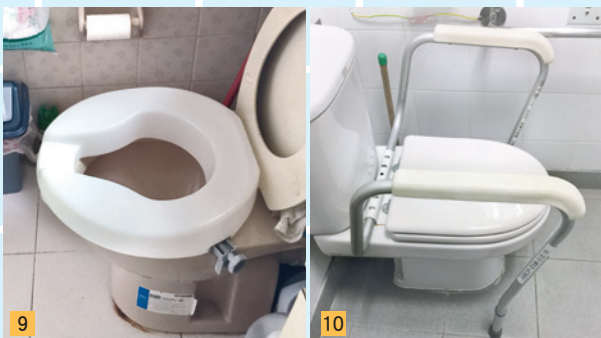
圖 9：如廁時轉姿勢有困難者，可考慮使用座廁加高器。安裝後的高度應為長者坐下時雙腳可以到地，而膝蓋約成 90 度彎曲。 圖 10：如座廁旁的牆壁難以安裝扶手或空間有限，視乎座廁款式，可考慮安裝座廁扶手架，協助坐低及起立有困難的長者。
