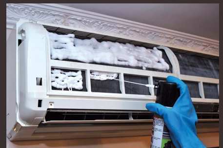
在冷凍葉上噴上冷氣機專用的清潔劑，使用附有噴嘴的產品較方便，減少清潔劑四濺的情況。
